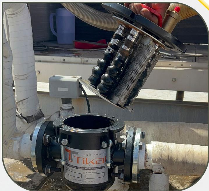
با خارج کردن لجن سیاه از سیکل های بسته میتوان از آسیب های تجهیزات جلوگیری کرد و با خنثی کردن خرابی های ناشی از این رسوبات فلزی، امکان حفاظت حداقلی از تمام تجهیزات به کار رفته در سیکل فراهم میشود.
